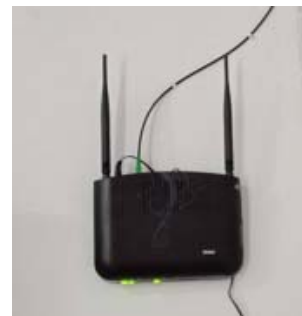
ภายในอาคารก่อนเข้า ONU/ONT
